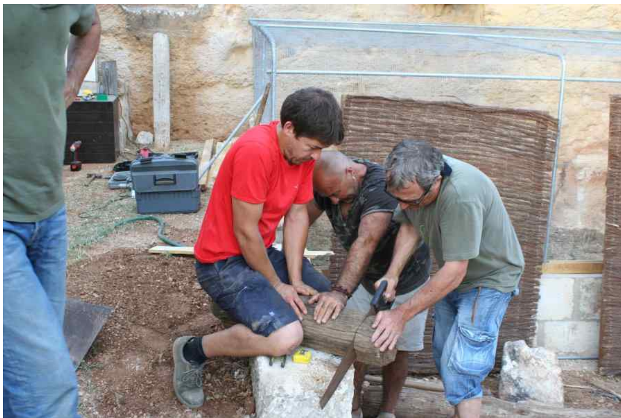
Voluntaris treballant en la reforma de les infraestructures
